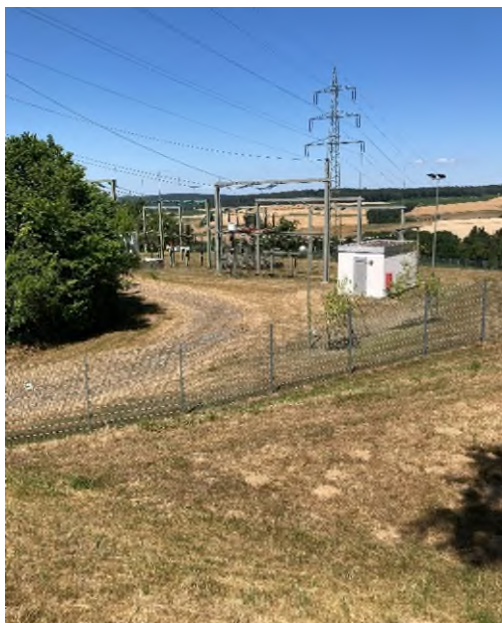
Abbildung 11: Blick von Südosten auf das nordwestlich gelegene Gelände des Umspannwerks
